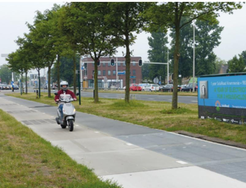
Photokatalytische Radwegoberfläche (Krommenie, NL).
