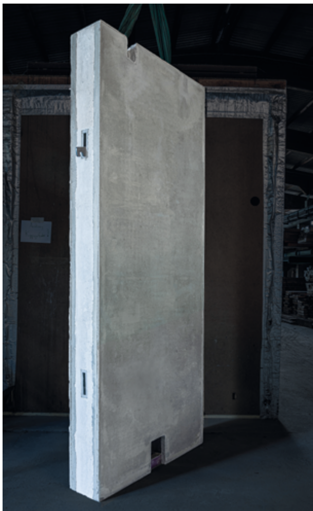
Eine vorgefertigte Wand aus Gradientenbeton.
