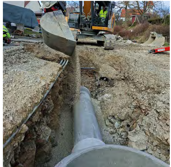
Einbau der Betonrohre in Bleichstetten.
