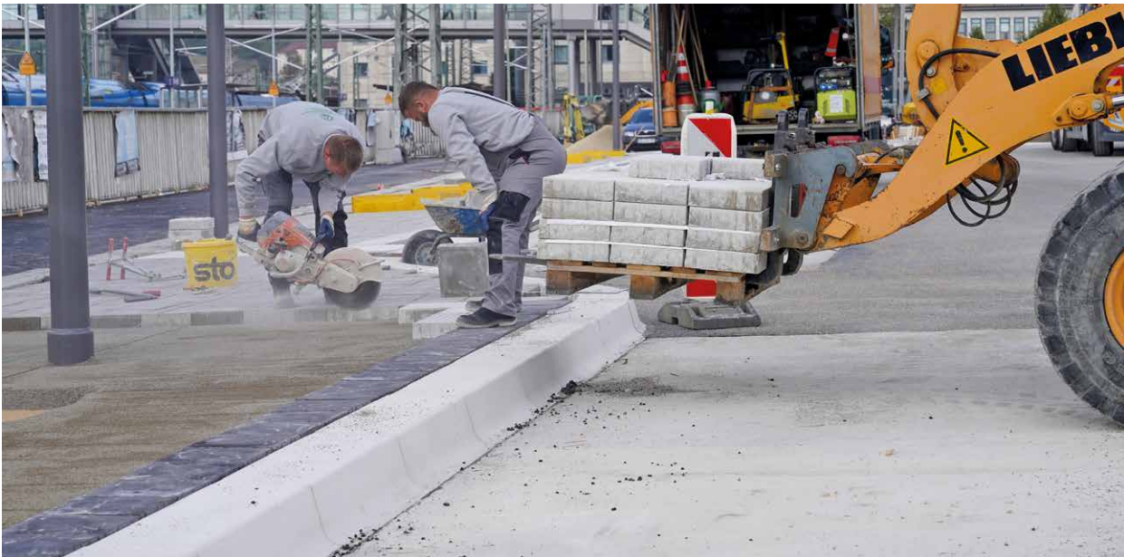
Präzisionsarbeit auf der Baustelle.
