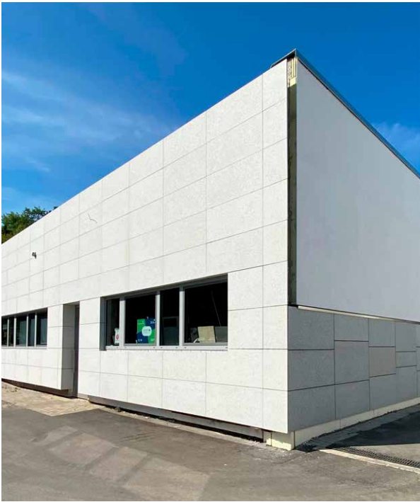
Abb. 6: (links) Bürogebäude mit wiederverwendeter betoShell®-FLEX30 Fassade, (oben rechts) RC-Gesteinskörnung aus betoShell® FLEX30, (unten rechts) Gehwegplatten mit 65 % RC-Material.
