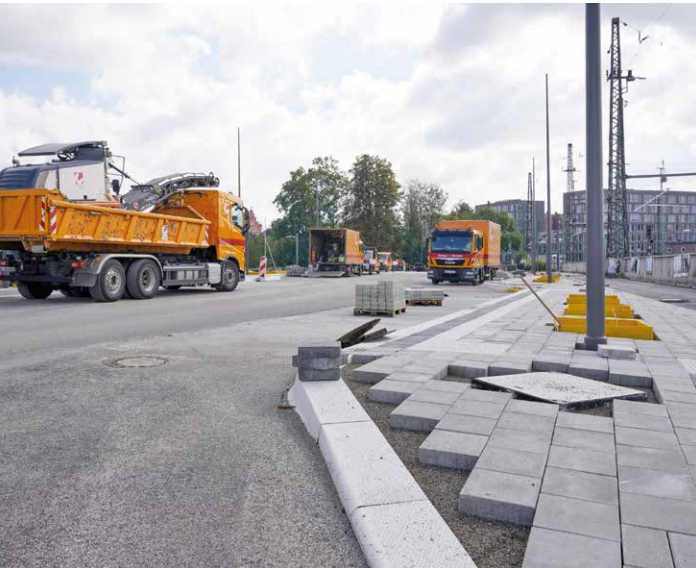
Am ZOB Ulm entstehen Straßen- und Haltestellenflächen – Betonsteine und Bordlösungen schaffen eine langlebige, barrierefreie Infrastruktur.
