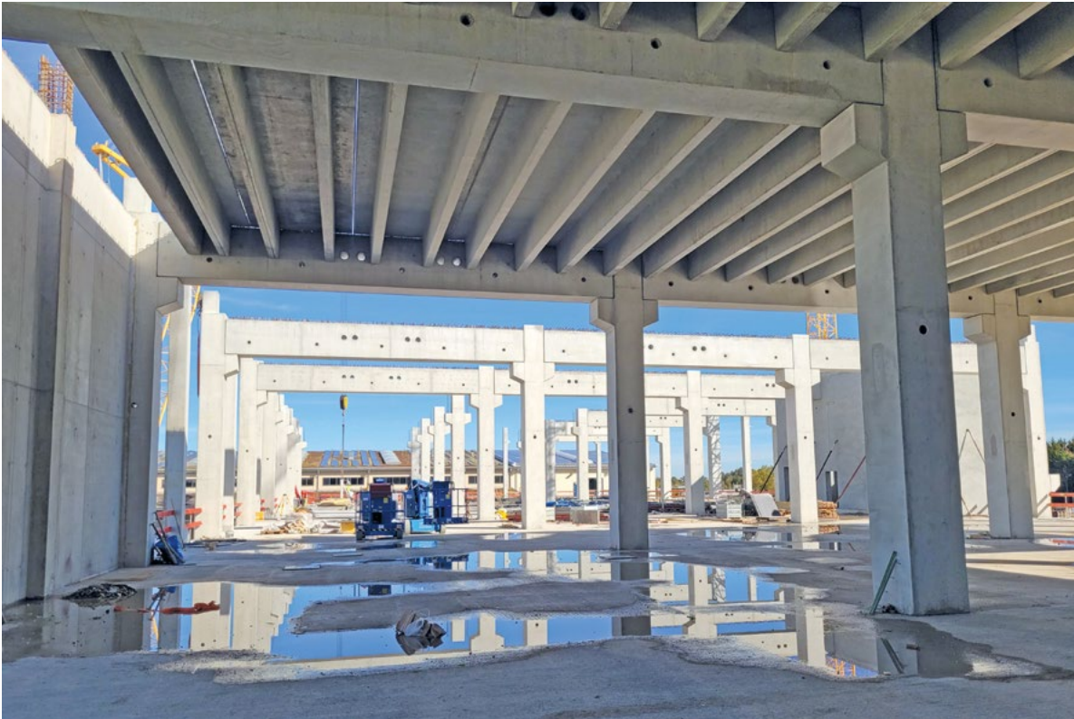
Teilmontierte Decke im neuen Abfüllzentrum des Augustiner Bräu München.
