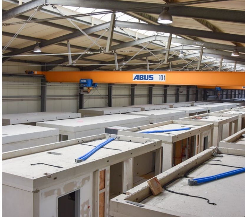
Seriell vorgefertigte Module im Werk.
