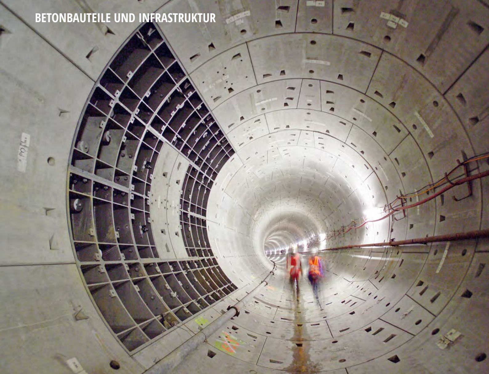
Tunnelröhre aus Tübbingen.
