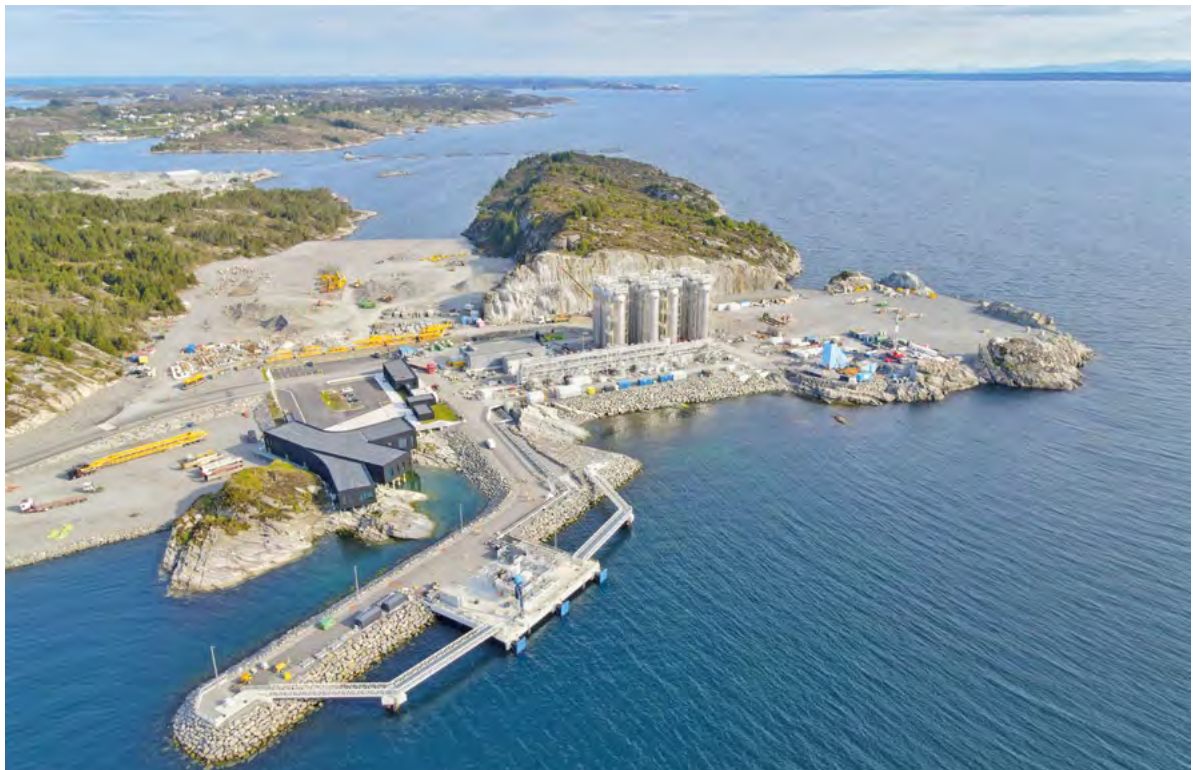
Onshore-CO 2 -Empfangsterminal vom Northern-Lights Projekt in Norwegen.
