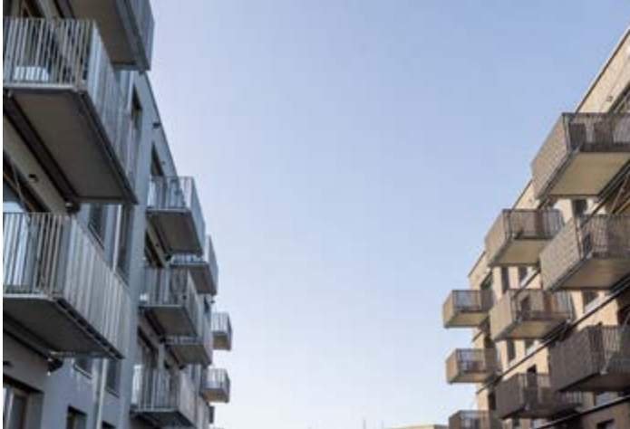
Mit Carbongittern bewehrte Balkonplatten St. Vinzenz Wangen.
