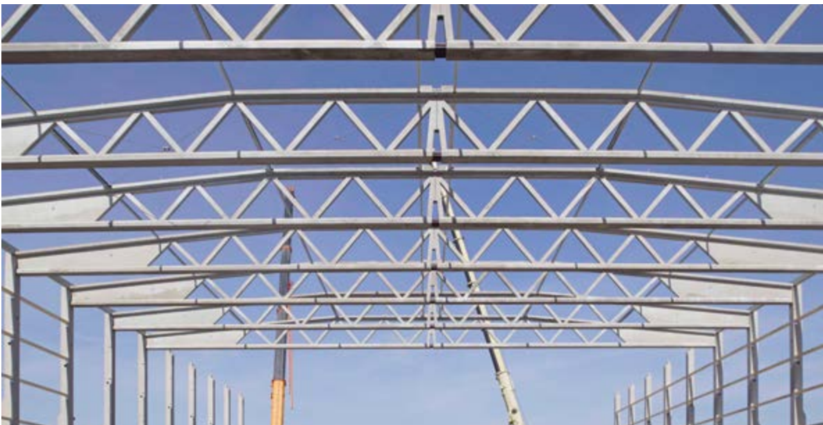
Dachtragwerk im Montagezustand.
