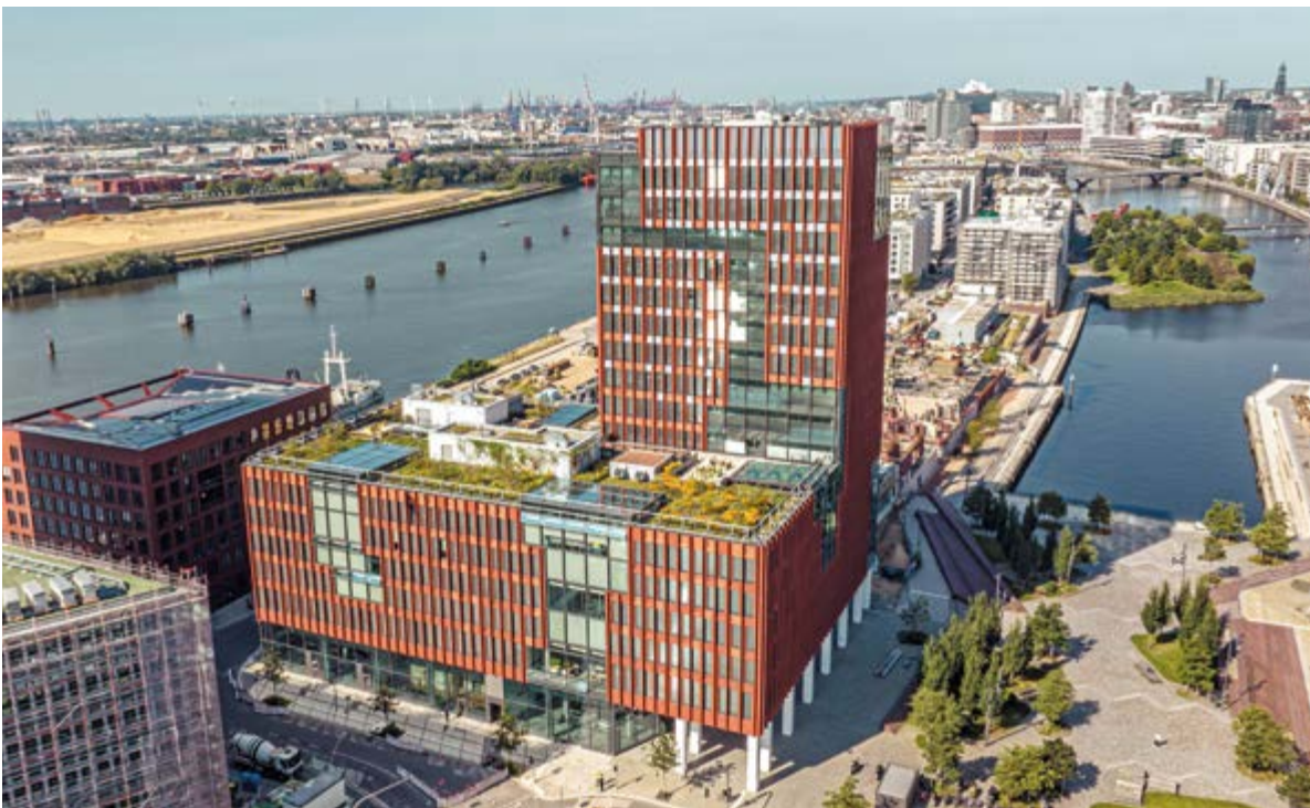
EDGE ElbSide ist das höchste Bürogebäude Deutschlands in Slim-Floor-Konstruktion.
