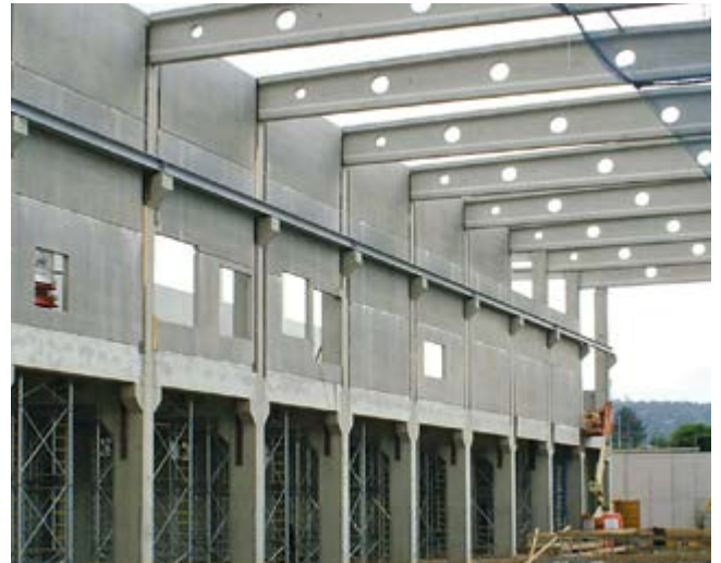
Beispiel: Halle mit Kranbahn-Stützen mit Konsole zur Auflagerung einer Kranbahn.
