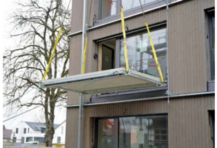
Einheben einer Balkonplatte.
