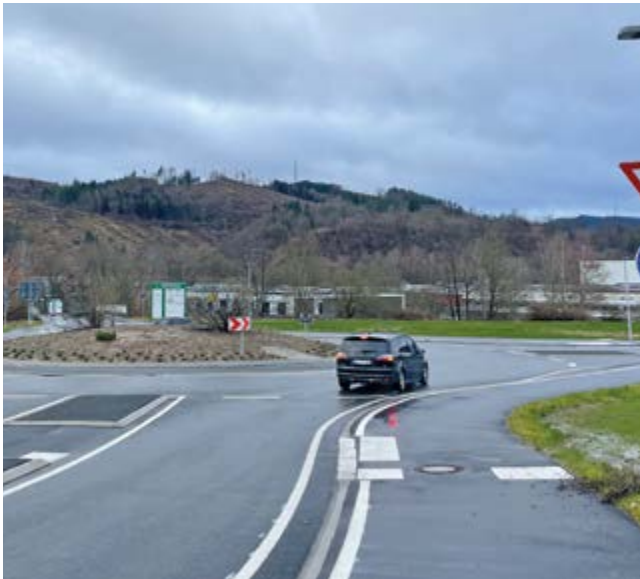
Entsprechend der Gestaltungsgrundsätze für KVP wurden in allen vier Kreiszufahrten barrierefreie Fahrbahnteiler angelegt.
