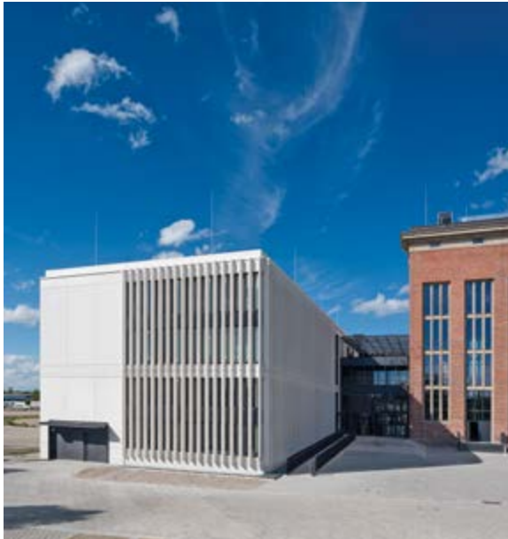
© Laumer Bautechnik GmbH
