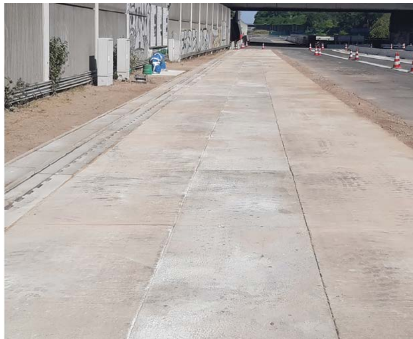
Versuchsstrecke mit Fertigteilmodulen.
