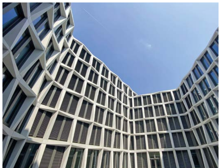
Bild 7: Architekturbetonfassade als lastabtragende Außenwand, BWE-Bau.
