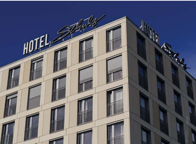
Bild 4: Dünne Fassadenelemente aus hochfestem und unbewehrtem Beton, Drössler Betonfertigteile.
