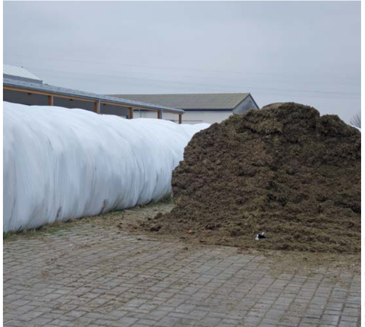
Betonpflasterfläche für die Schlauchsilierung.
