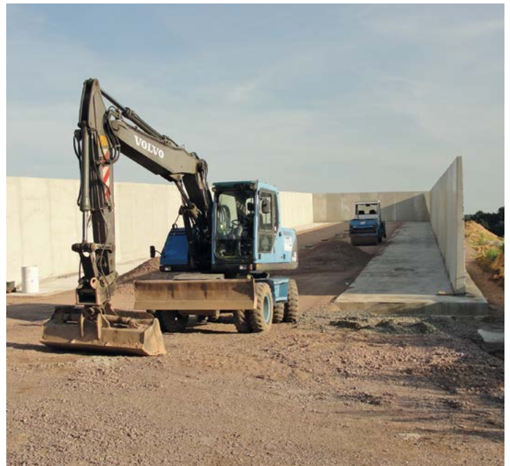
Fahrsilobau mit Fertigteilwänden.
