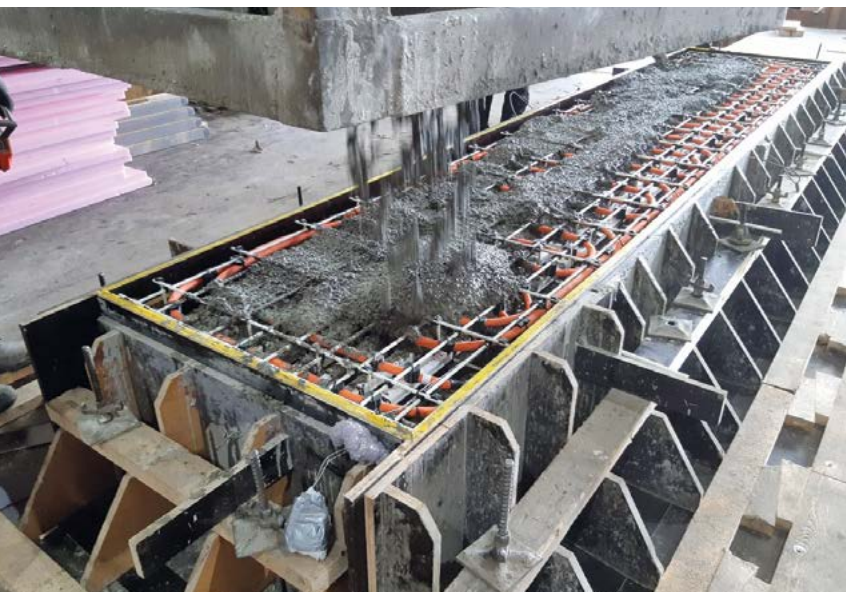
Herstellung eines Fertigteilmoduls mit integrierter Spule.
