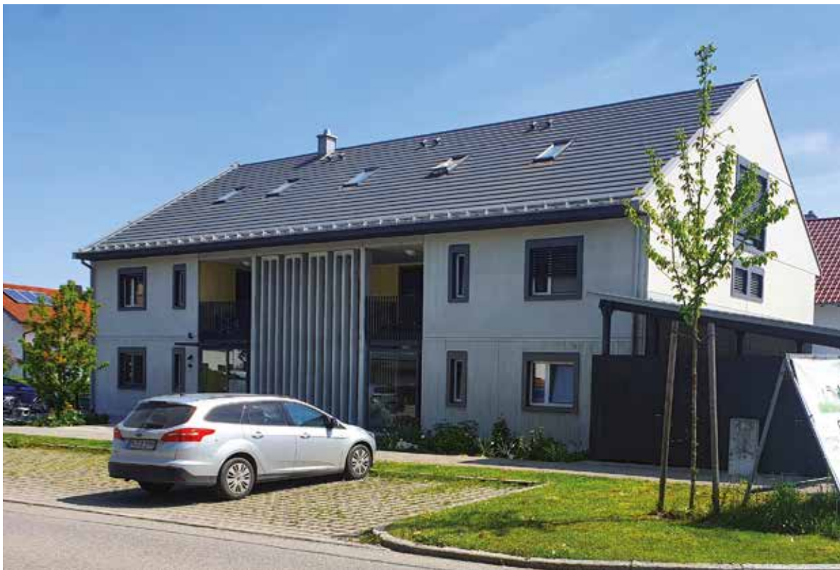
Das Mehrfamilienhaus in Gars am Inn mit acht Wohneinheiten wurde komplett aus Betonfertigteilen gebaut.
