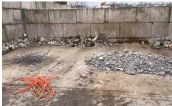
Das erfolgreiche Ergebnis der sortenreinen Trennung: Stahl, Beton und PEX-Rohre.
