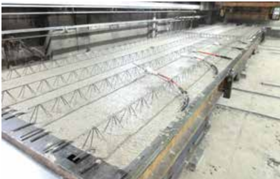
Frisch betonierte LTKH-Klimadecken.
