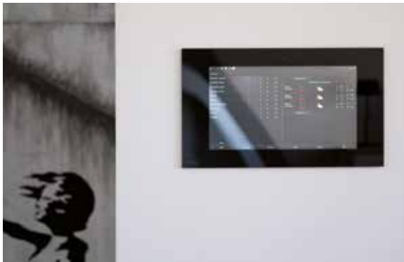
Das Energiemanagement erfolgt im gesamten Haus per Touch-Screens in BUS-Technik.
