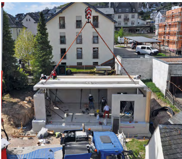
Montage der weitgespannten Deckenplatte für eine Moduleinheit.
