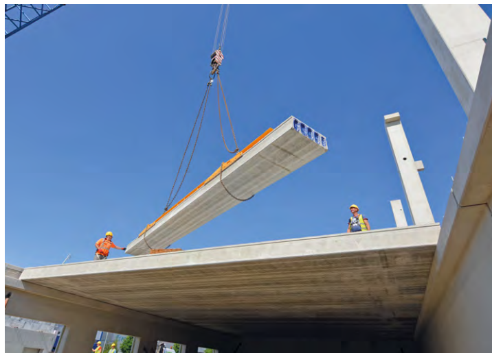
Verlegung einer Spannbetonfertigdecke.
