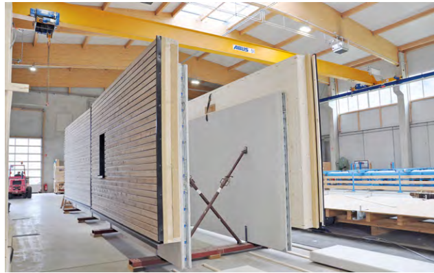
Werkseitige Herstellung der Hybridwand in Holz-Beton-Verbund.
