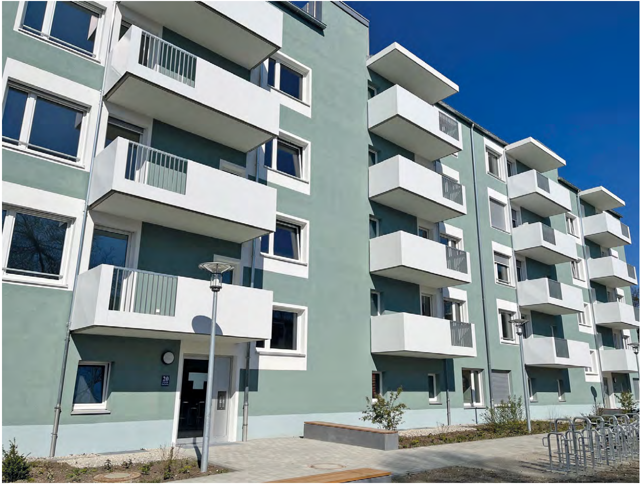
März 2021: Der Rohbau ist komplett.
