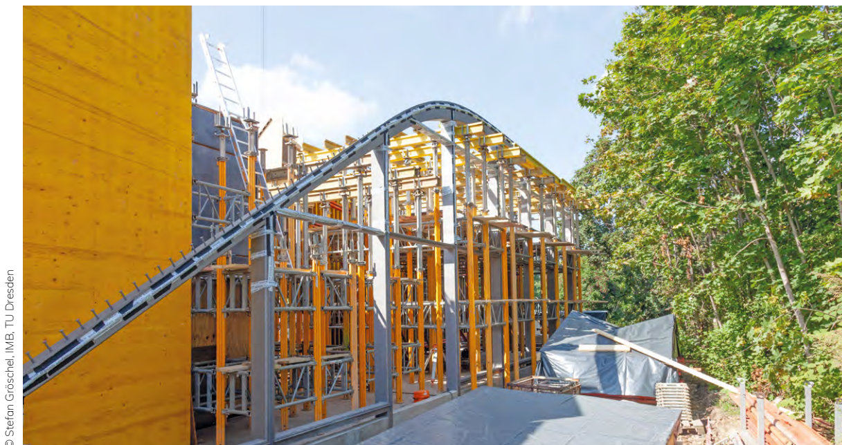
Aufbau der TWIST-Schalung.
