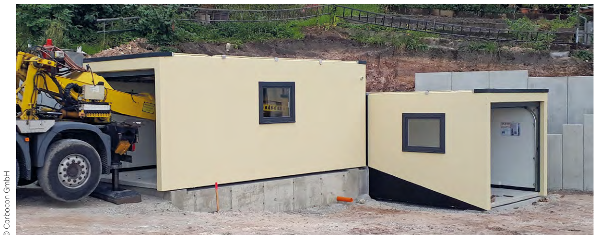
Aufstellen der Prototypen mit Bodenplatte aus Carbon-/Textilbeton im Raum Dresden.
