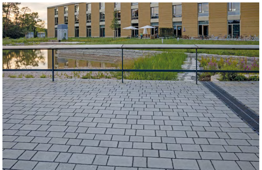
Alle eingesetzten Bodenbeläge wurden aus Betonstein mit Recyclinganteil gefertigt.
