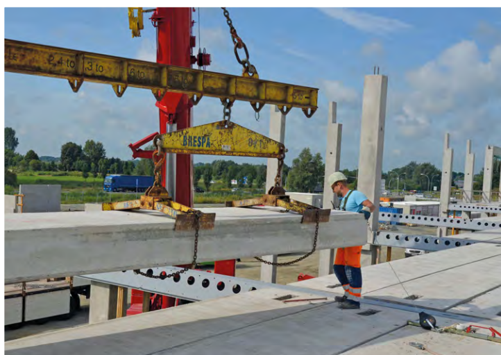
Montage der Spannbeton-Fertigdecken.
