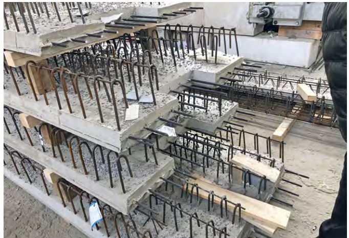
Abb. 5: Spannbettvorspannung für die vorgefertigten Gurtstreifenplatten.
